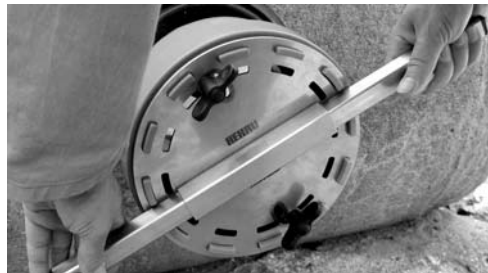
AWADOCK-Einschraubkrone in die Anschlussdichtung einschrauben
