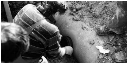
AWADOCK-Anschlussdichtung in die Bohrung einführen
