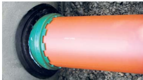
Rohr bis zum Anschlag in die AWADOCK-Einschraubkrone einstecken
