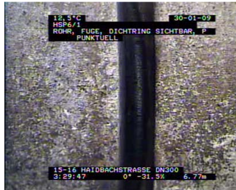
Zustandserfassung mittels Kanal-TV
