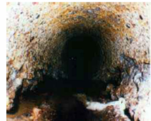
Korrosion
