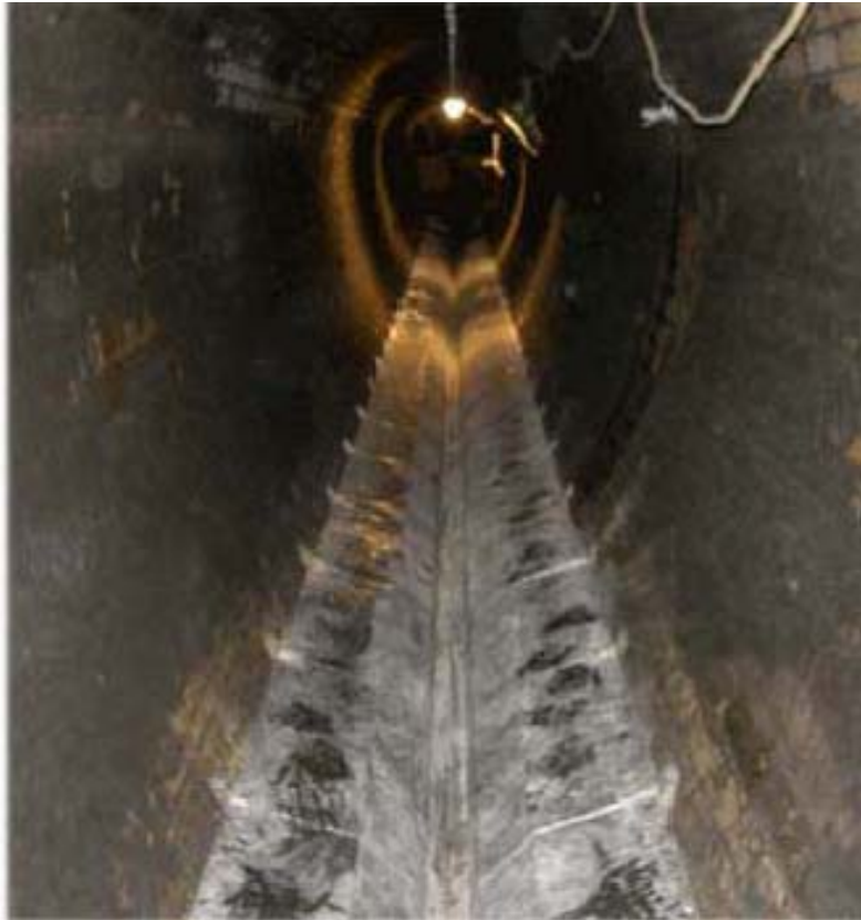
Nachträglicher Einbau des Wärmetauschers (Uhrig in Müller, 2010)
